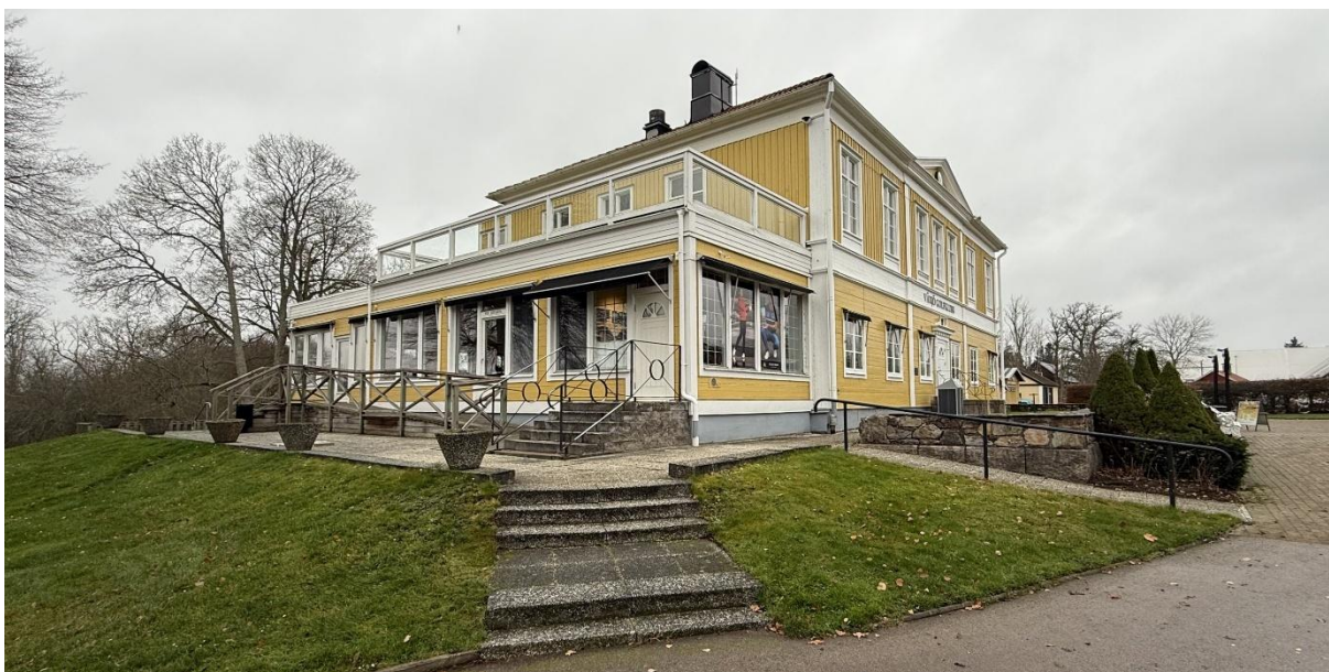
Byggnadens södra gavel i vy mot nordväst. Sidobyggnaden skiljer sig från huvudbyggnaden genom sina stora glasytor, men anknyter till helheten genom fasader av träpanel och färgsättning i gult och vitt. Tillgängligheten löses idag med hjälp av en betongstensbelagd ramp, till höger i bild, som leder upp till en altan med dylik betongstensbeläggning. Härifrån nås byggnaden via en längre träramp av omålat virke.
