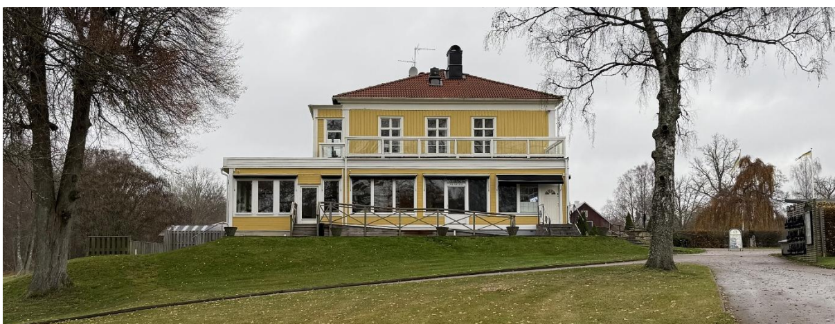
Södra gaveln och sidobyggnaden i vy mot norr. Notera den långa rampen av omålat virke.
