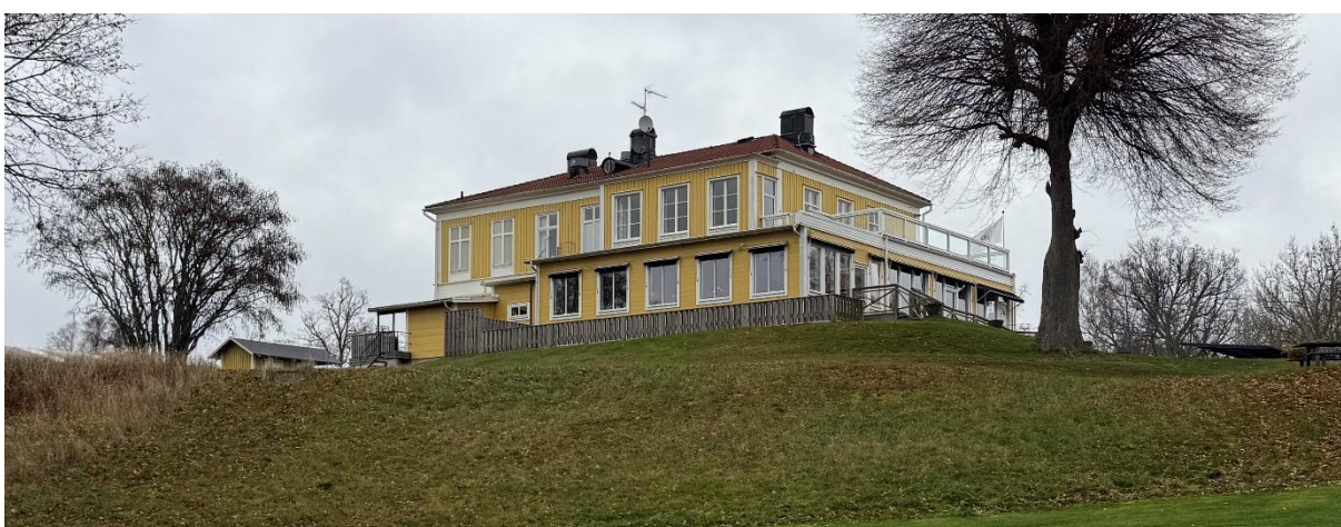
Byggnaden i vy mot nordost. Sidobyggnaden är sedan 2010 förlängd utmed husets västra långsida. Den anslutande altanen/uteplatsen omsluts av ett plankliknande räcke, som liksom rampen är av omålat trä och därmed upplevs avvikande i herrgårdsmiljön.
