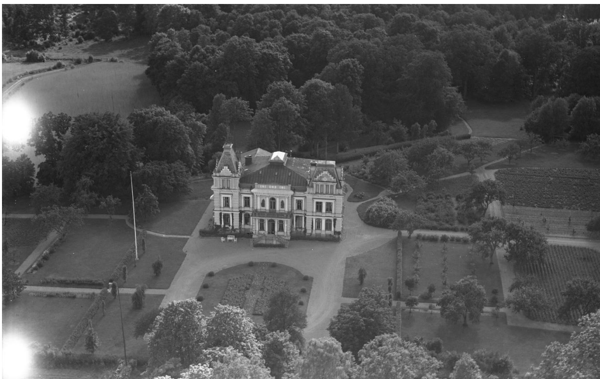
Flygfoto över herrgården, 1936. Godsägare vid denna tid var fänrik Nils Bertil Aschan. Herr Aschan med familj bodde dock i en intilliggande byggnad, benämnd inspektorsbostaden (strax utanför bild). Huvudbyggnaden disponerades istället av dennes mor, änkan Sophie Aschan, som två år efter att fotot togs lät genomföra en omfattande ombyggnad. Källa: Smålands museums fotosamling.
